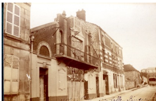
Le cinéma Pinson, après sa destruction en mai 1918
