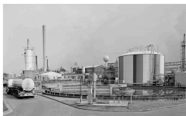
La station d'épuration construite vers 1970. Phot. Patrick Glotain IVR22_19936000537X
