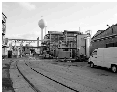
Atelier de fabrication et château d'eau. Phot. Thierry Lefébure IVR22_19926000357X
