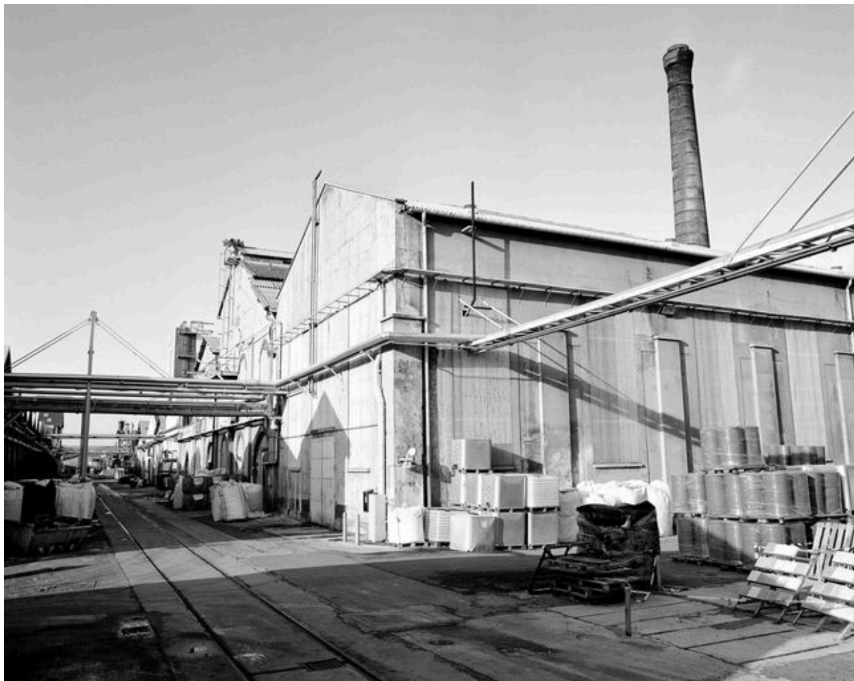
Chaufferie : flanc sud est.
