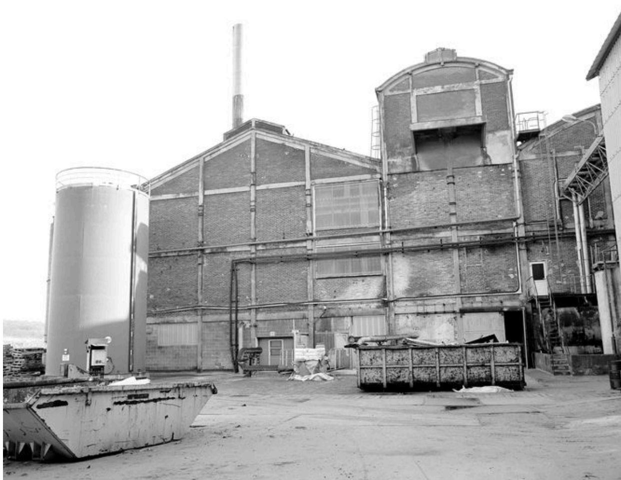
Ateliers de fabrication et chaufferie : flanc ouest.
