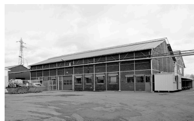
Bâtiment construit vers 1925-1930. Phot. Thierry Lefébure IVR22_19926000350X
