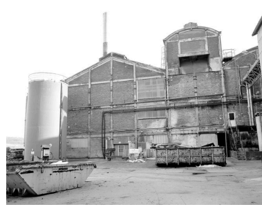
Ateliers de fabrication et chaufferie : flanc ouest. Phot. Thierry Lefébure IVR22_19926000338X
