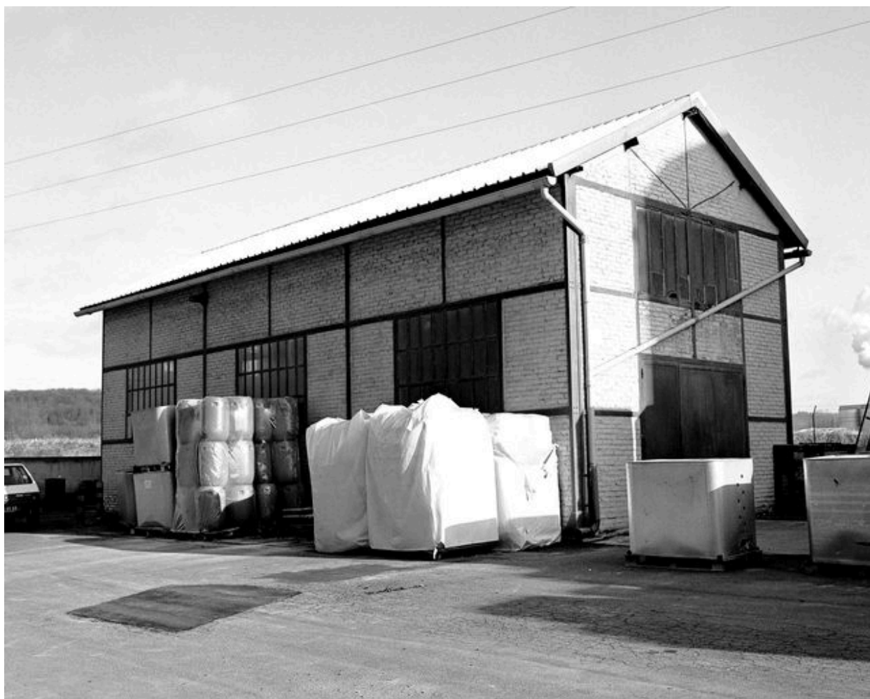
Chaufferie : flanc nord.
