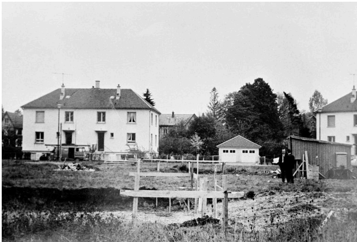
Construction de logements pour les cadres, vers 1959-1964 (AP).
