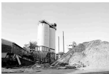
Aire des matières premières et réservoirs industriels : flanc nord. Phot. Thierry Lefébure IVR22_19926000336X
