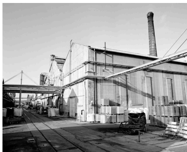
Chaufferie : flanc sud est. Phot. Thierry Lefébure IVR22_19926000367X
