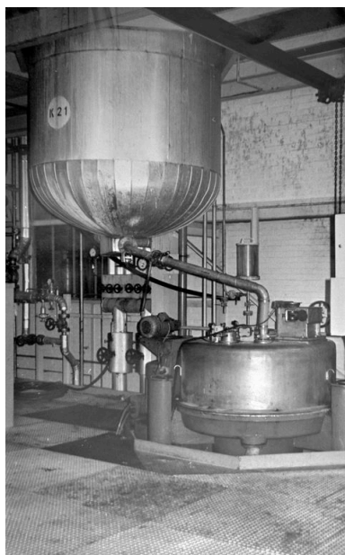
Intérieur d'un atelier de fabrication non identifié (AP). Repro. Glotain Patrick IVR22_19936000491XB
