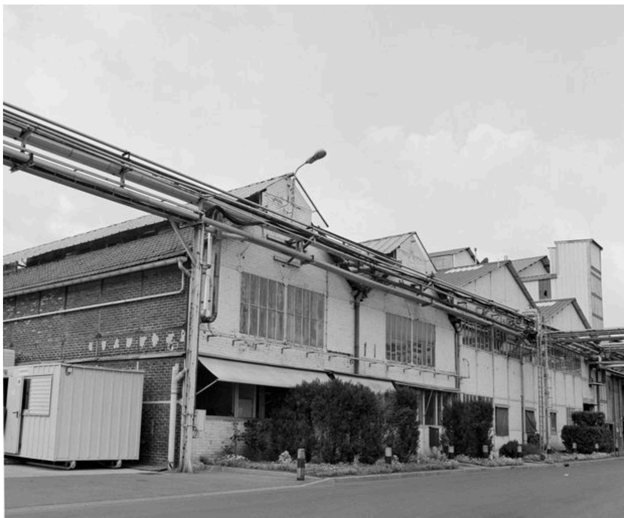
Atelier de fabrication antérieur à 1960.
