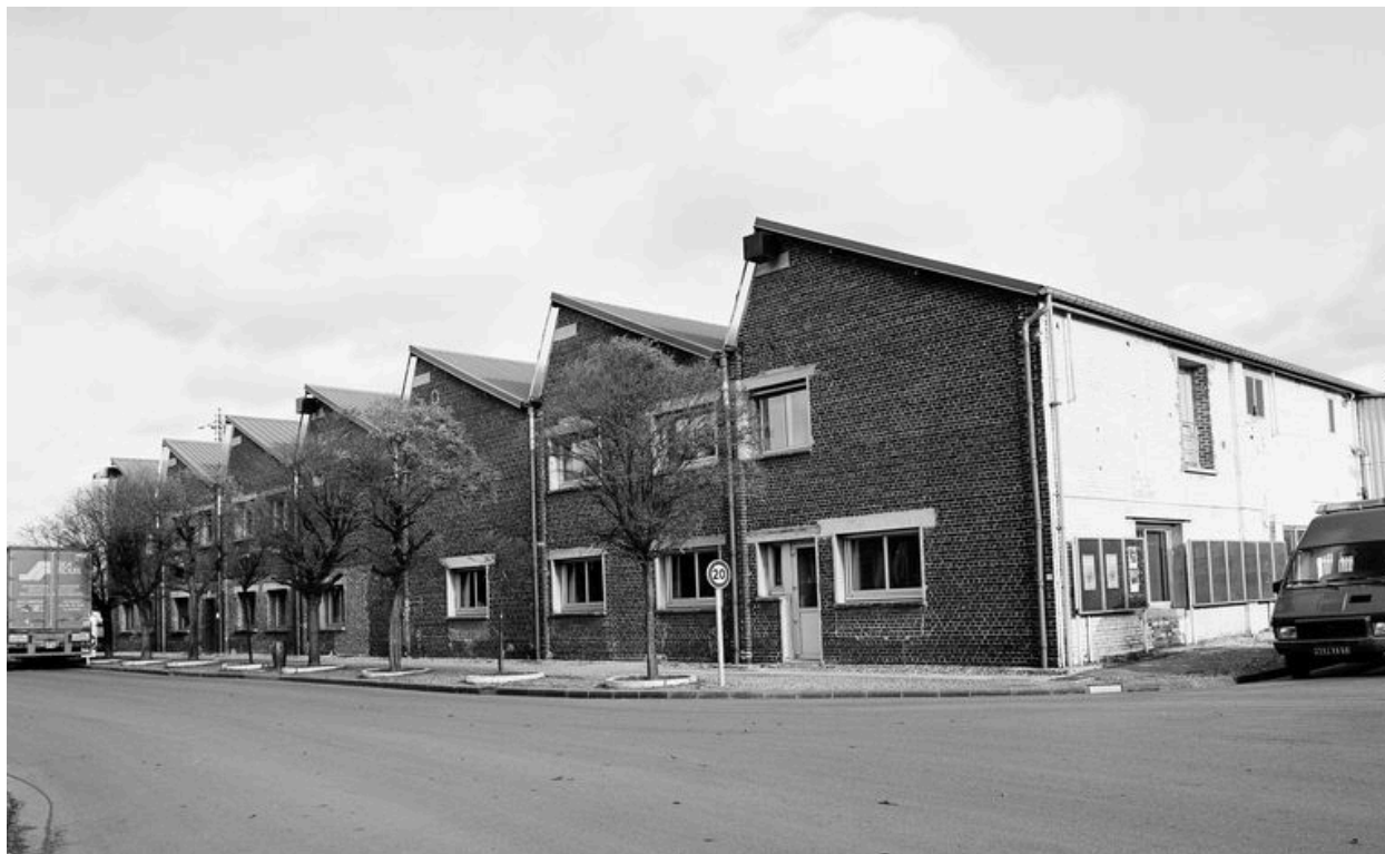
Ateliers de fabrication avec sheds construits vers 1925.
