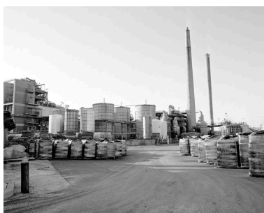
Réservoirs industriels. Phot. Thierry Lefébure IVR22_19926000341X
