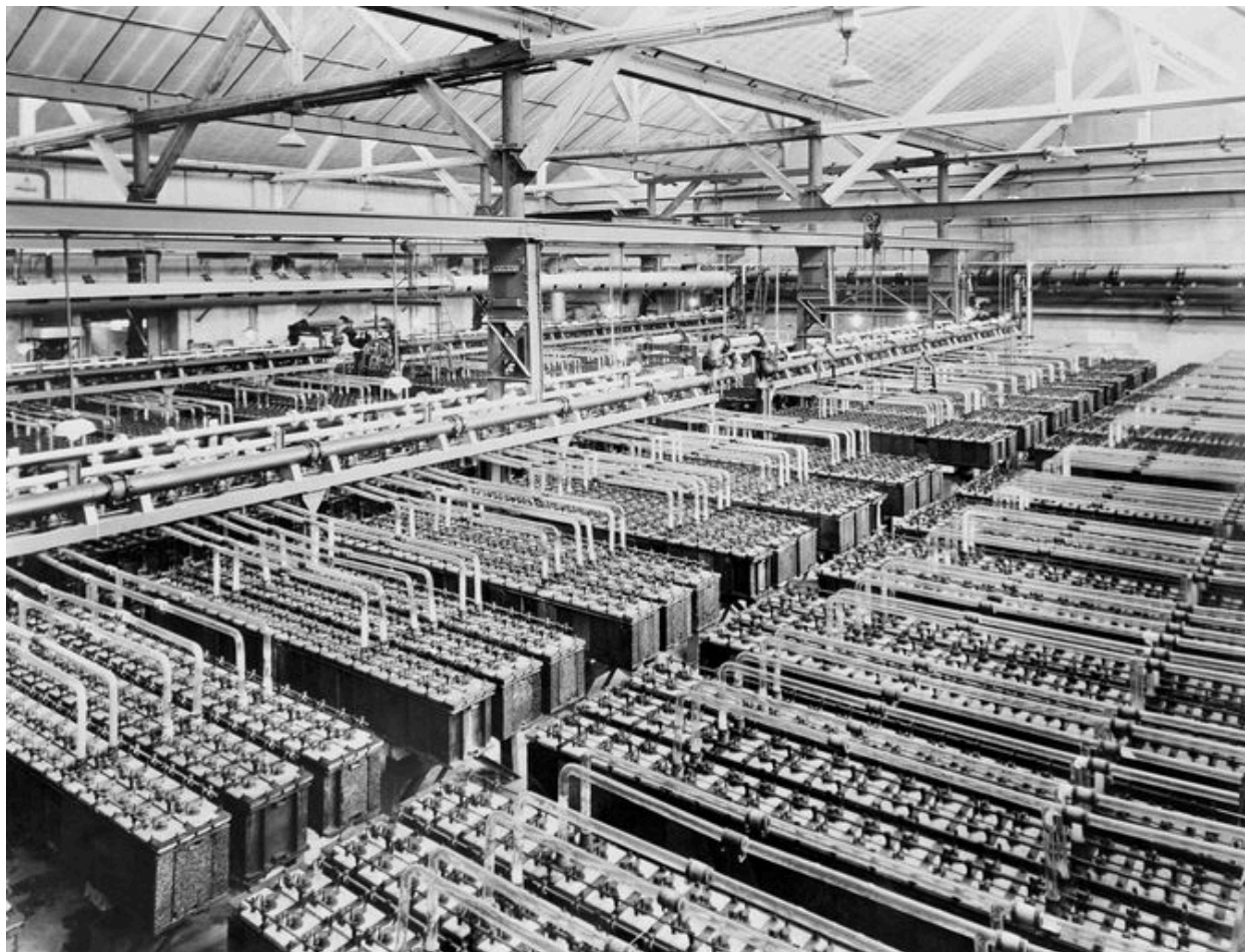
Vue intérieure de l'atelier d'électrolyse (AP).
