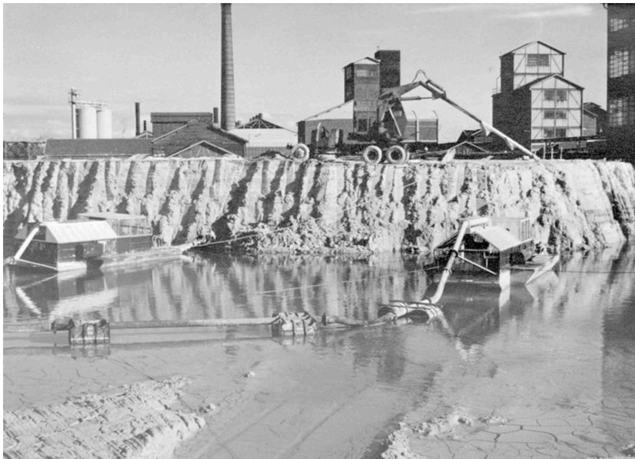
Travaux de terrassement (AP).
