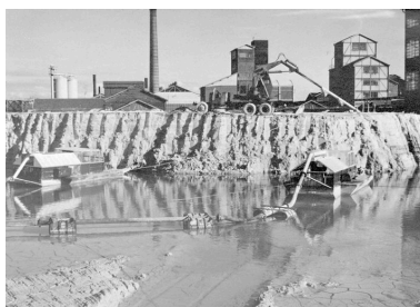
Travaux de terrassement (AP). Repro. Glotain Patrick IVR22_19936000482XB
