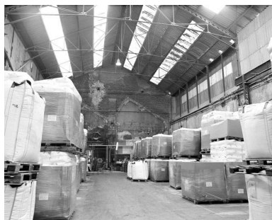
Chaufferie : vue intérieure. Phot. Thierry Lefébure IVR22_19926000375X
