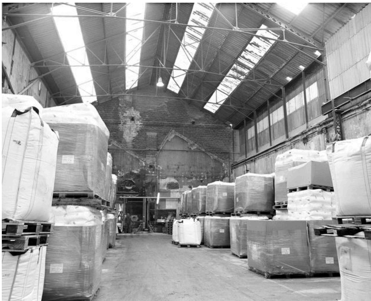
Chaufferie : vue intérieure.
