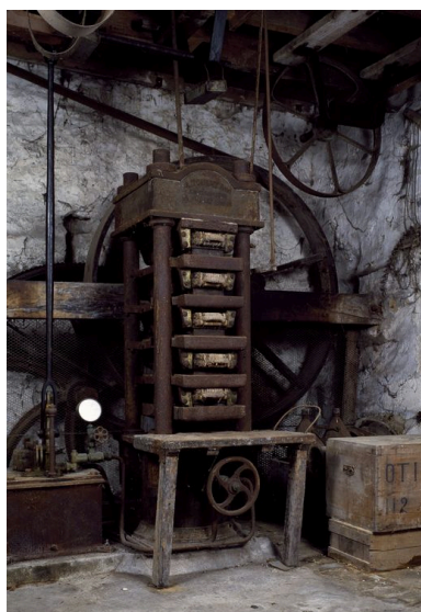
Presse hydraulique Toulet et transmissions. Phot. Olivier Coquelle IVR22_19946000938XA
