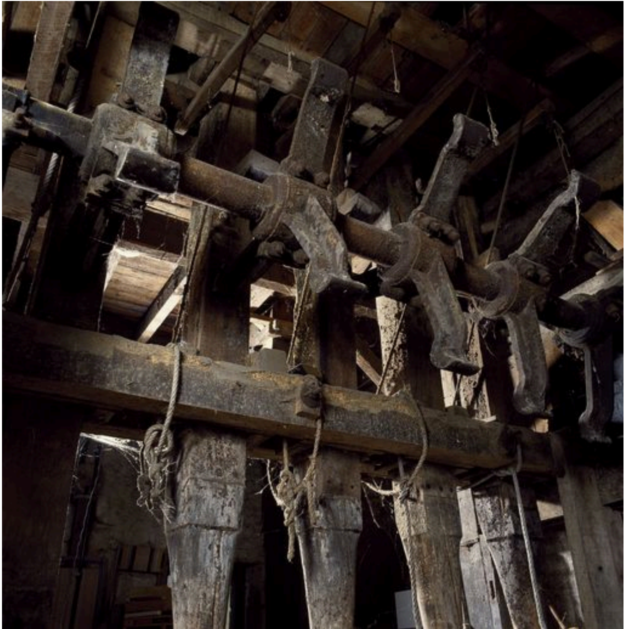
Détail du palier de la roue hydraulique.
