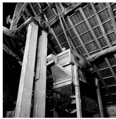
Système élévatoire. Phot. Olivier Coquelle IVR22_19946000915X
