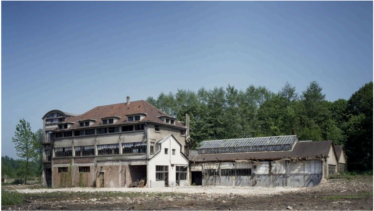
Atelier de fabrication modifié vers 1930 puis 1950 : façade sud.
