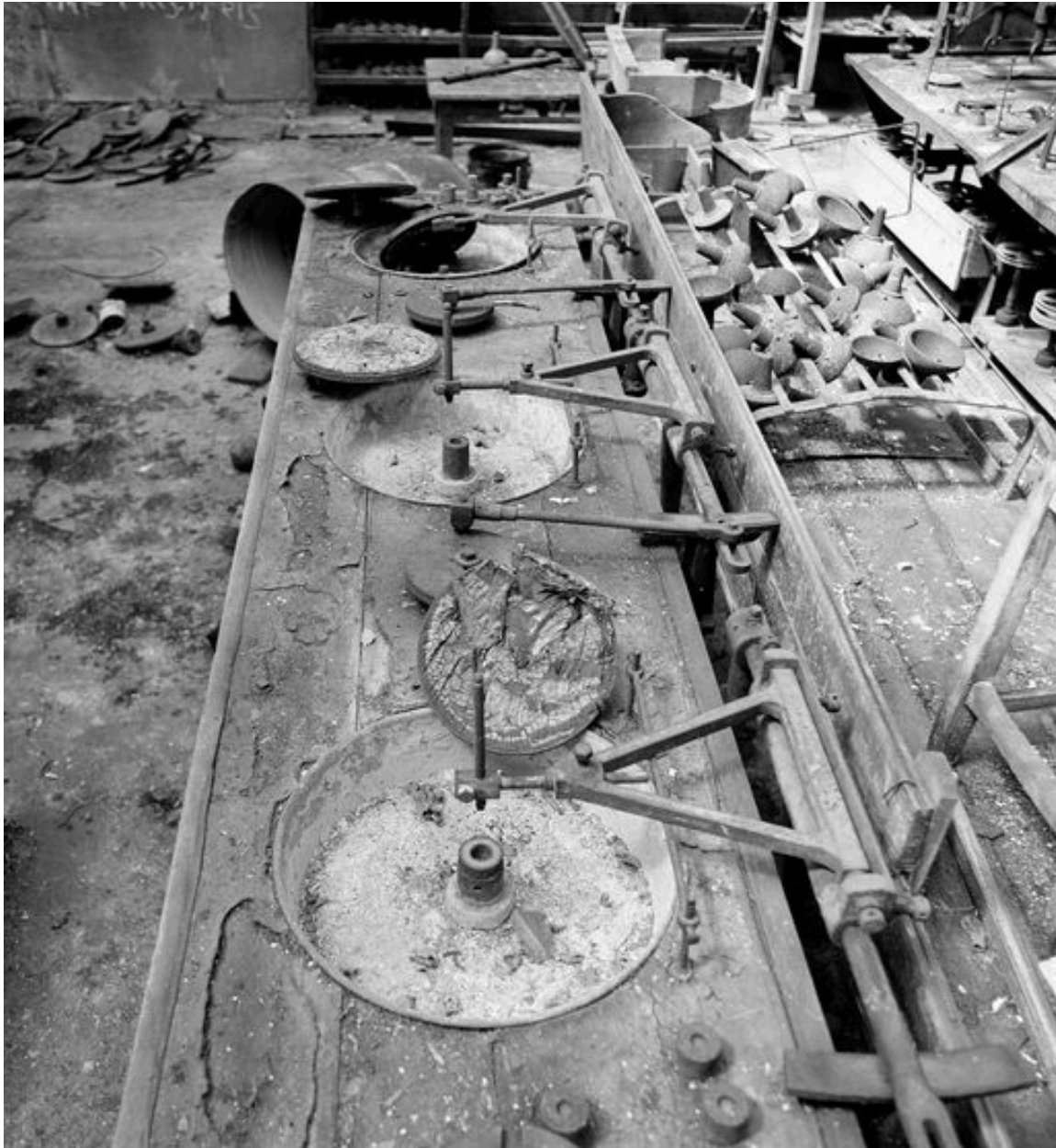
L'atelier de fabrication reconstruit après la guerre, banc de polissage.
