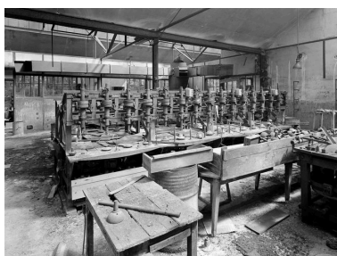
Atelier de fabrication reconstruit après la guerre : banc de polissage. Phot. Patrick Glotain IVR22_19936000705V
