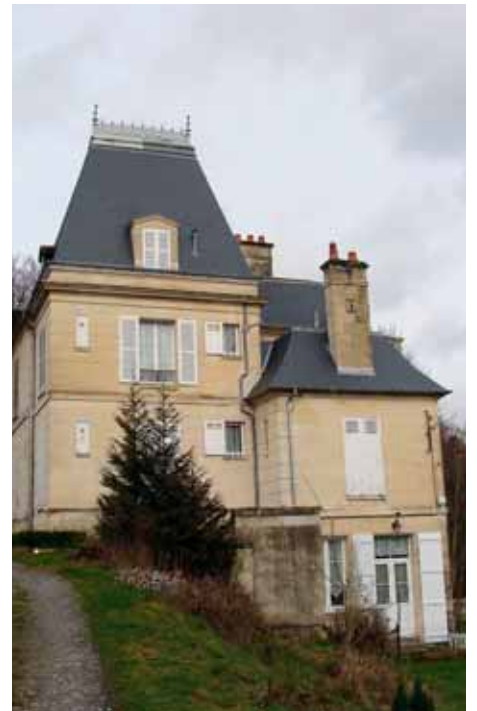
Pignon donnant sur le chemin d'accès
