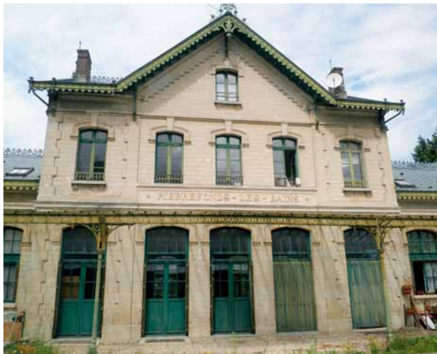
Façade arrière de la gare de la Compagnie des Chemins de fer du Nord.
