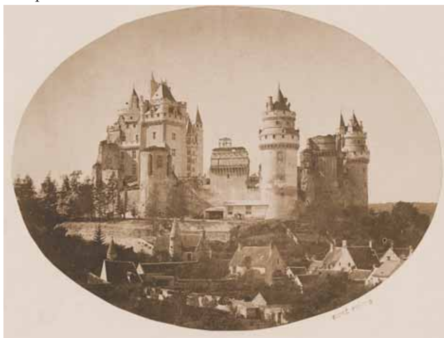
Vue de l'avancement des travaux, les murs présentent encore de larges brèches (Photo Dupré, Compiègne)
