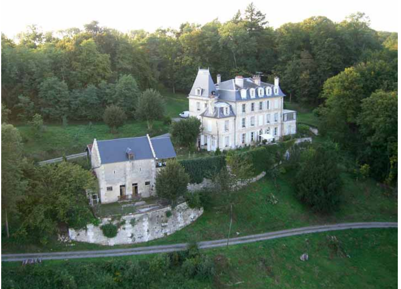
Façade arrière du château de la Follie et chemin d'accès. A gauche se trouve un bâtiment qui sert certainement d'écurie. On remarque l'importance des ouvrages de soutènement de l'ensemble situé sur l'amorce de la pente.
