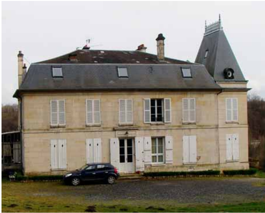
Façade avant. L'espace de vie principal, avec le salon, se situe au 1 er étage.
