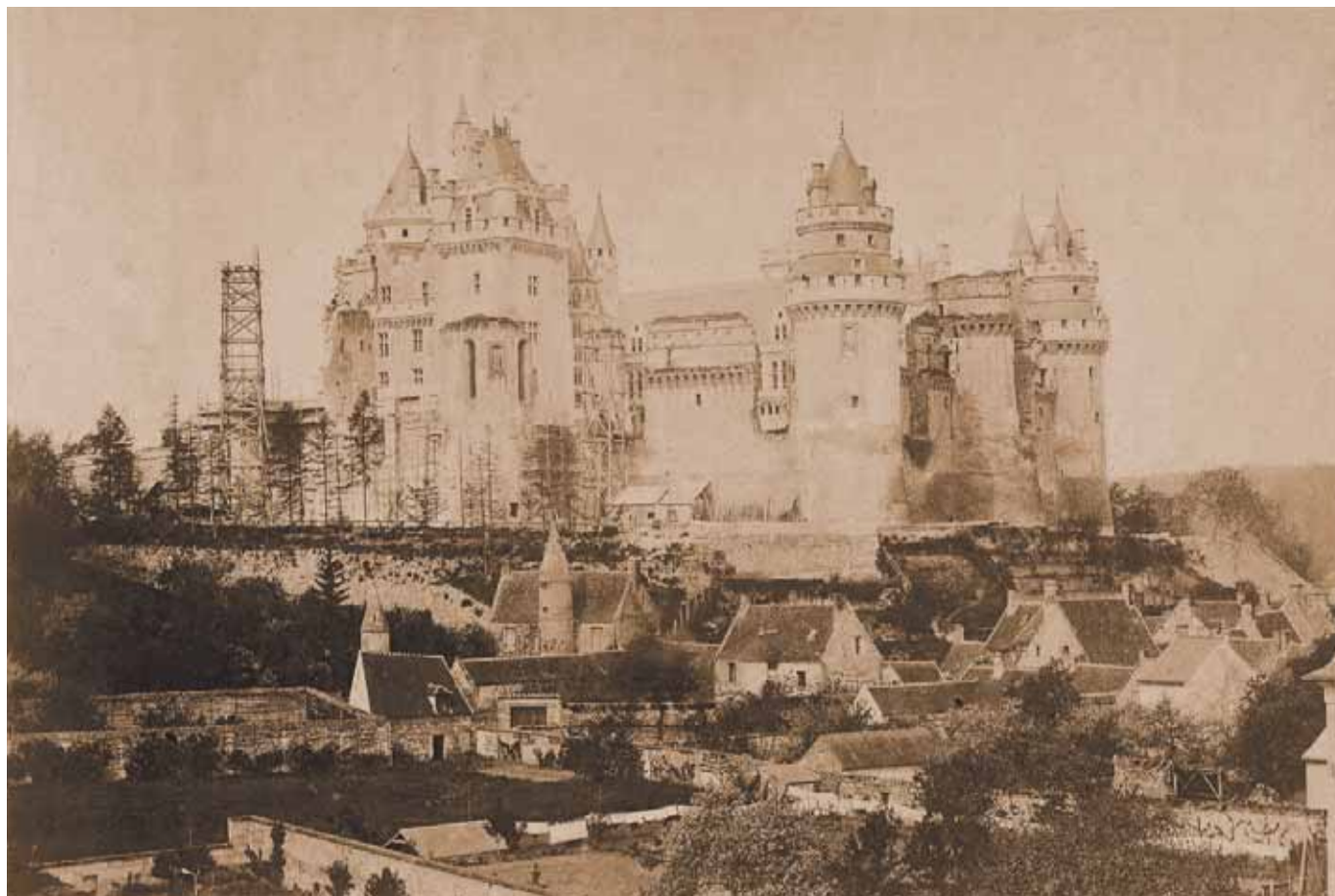
Le château en reconstruction : on distingue des échafaudages. Presqu'au centre, la maison avec une tourelle était celle de Wyganowski (Photo Dupré, Compiègne)
