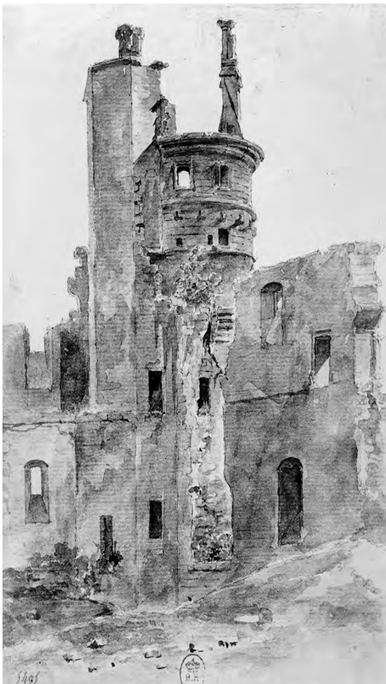
Fig. 41 - Le château de Pierrefonds, vue de l'angle entre les ailes nord-est (à gauche) et sud-est (à droite) avant restauration.
