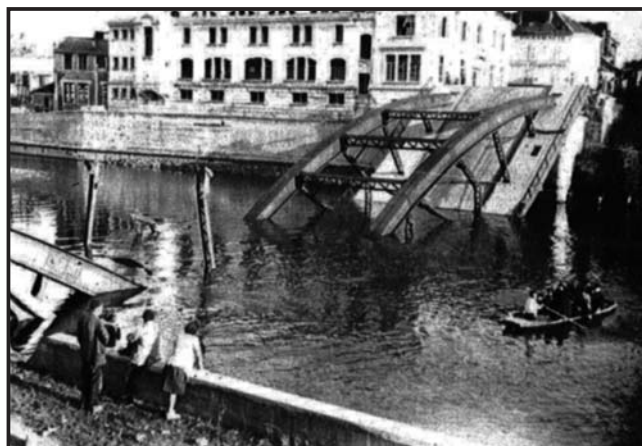
Le pont de Creil détruit, le 1 er septembre 1944.
