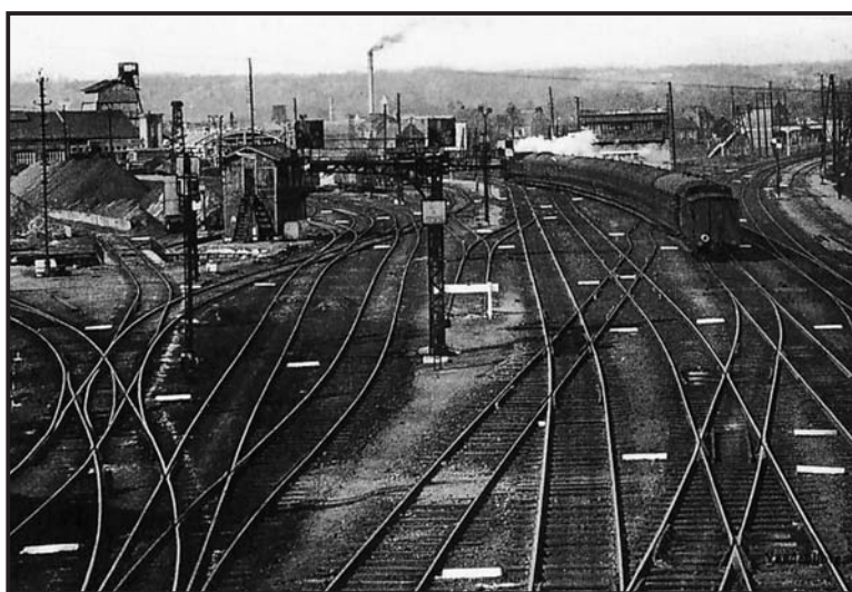
Le dépôt des machines de la SNCF.
