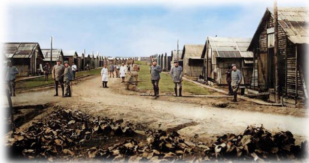
Allée centrale de l'hôpital
