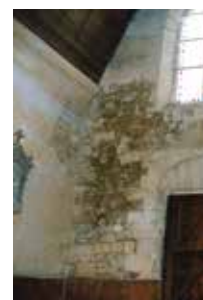
Le mur ouest de la nef, avant sa réfection, en 2004.
