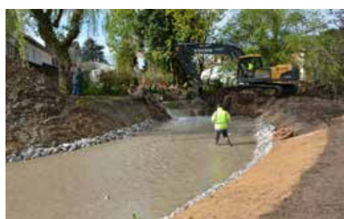
Ouverture du nouveau bras, près du moulin des Avenelles, le 26 avril 2016.
