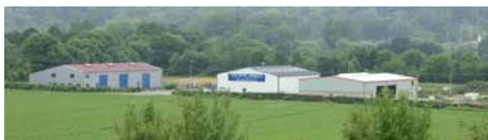
En 2009 (partie nord-ouest de la zone). Les entreprises Russo et Ledrappier sont implantées.
