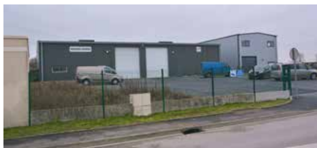
À gauche, le bâtiment des entreprises Fournà et MBI. À droite, celui de CEP et Néon Éclair (photo de 2018).
