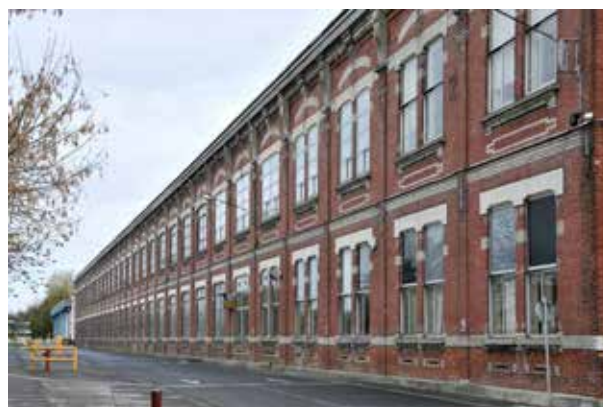
Le bâtiment principal de l'ex-soierie, bâti en 1926, et que la municipalité souhaite préserver.
