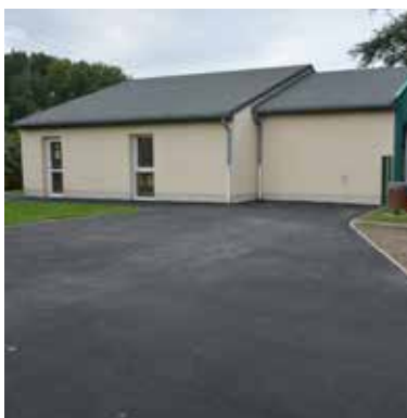
Accès à la salle du jeu d'arc.
