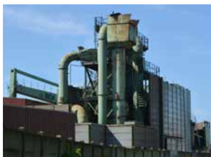
Une des installations du site de l'entreprise Brion (recyclage de métaux), créée en 1961, et qui s'est rapprochée du groupe belge Galloo en 2017.
