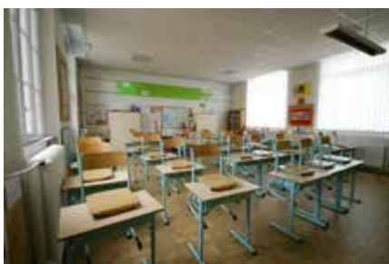
La salle de classe nord du bâtiment est (en 2008).
