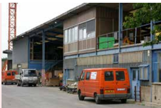
Site de stockage de l'entreprise Demouy, rue de Bienville (en 2006).
