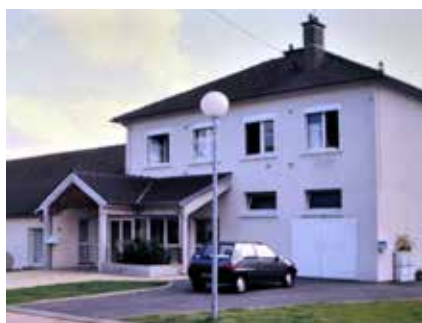
Avant la pose de grilles à l'entrée.
