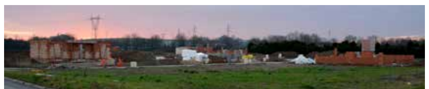
Vue vers le sud-ouest (janvier 2018).
