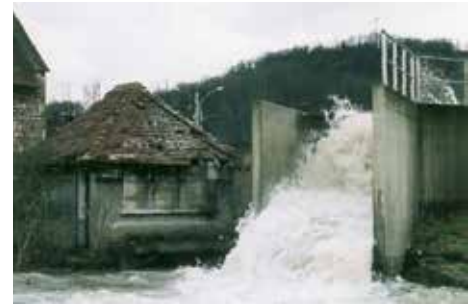
Le poste de crue en fonctionnement (début 2001).
