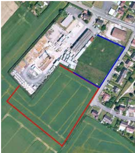
Une vue aérienne de 2013. Les deux lotissements jouxtent le terrain occupé par l'entreprise Demouy.
