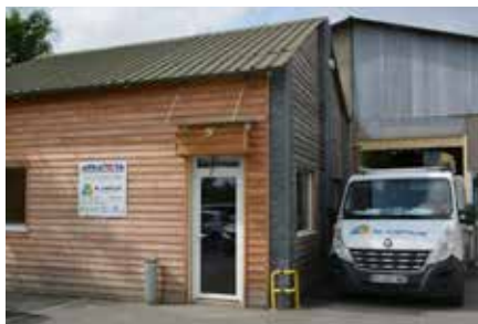
Le Camus (chauffage, climatisation...), au 227 rue de la République depuis 1994.
