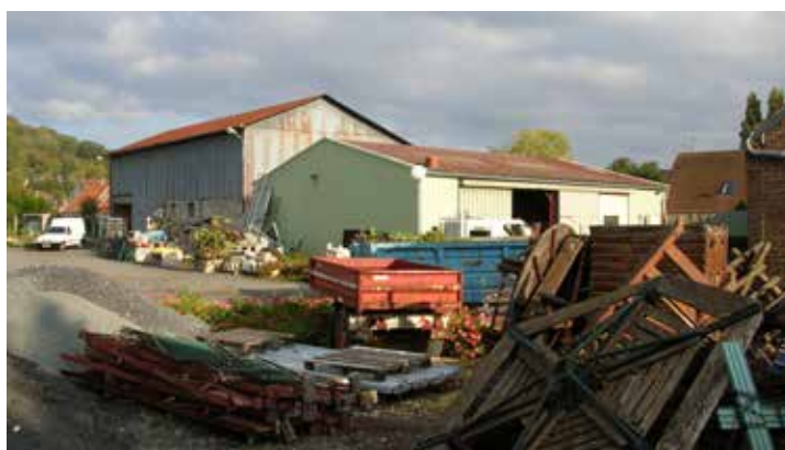
Les bâtiments des services techniques (photo de 2004) : bureau, ateliers, entrepôts, garage...
