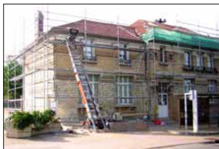
La réfection de la toiture (photo de juin 2010).
