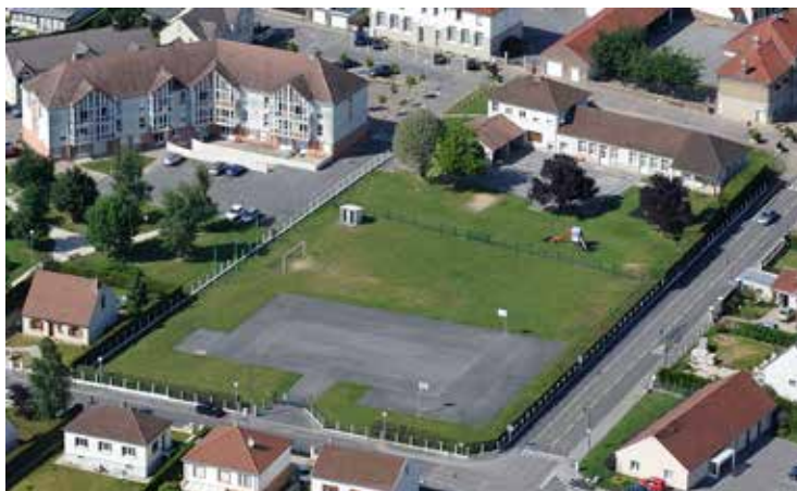
Le terrain où se construit le multipôle (vue de 2009).
