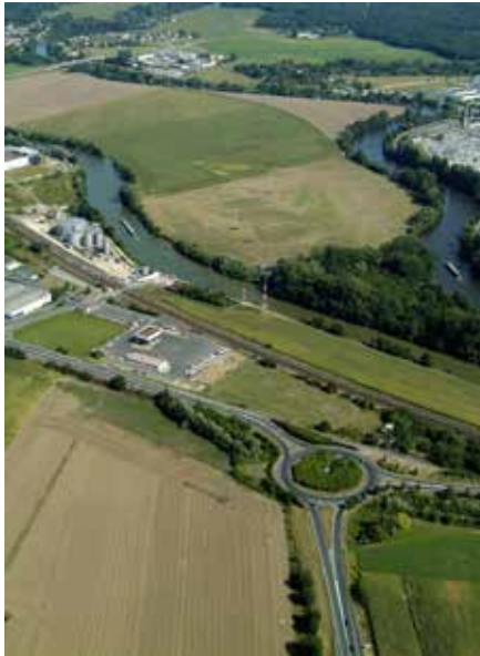
Avant la construction du viaduc.
