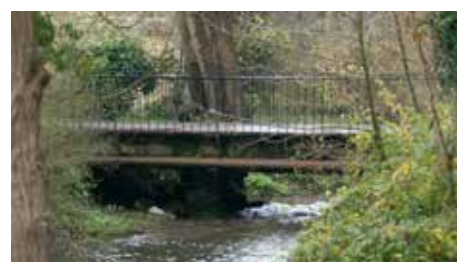
Le pont de la rue de la Bouloire, en 2006, sans sa passerelle piétonnière.
