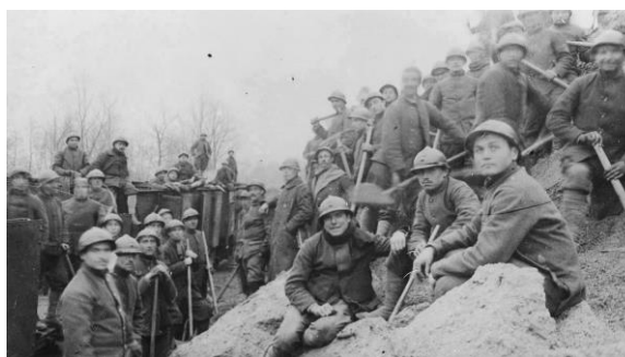
Soldats d'un régiment au repos à Clairoux en février 1917. Ils sont employés au chargement du sable de la zone humide de la Petite Couture. Ce matériau sera utilisé pour des ouvrages en béton (photo « La contemporaine » - BDIC).
