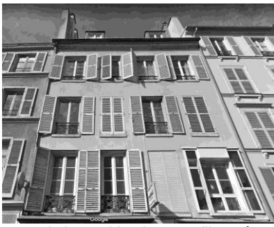
Le petit immeuble de Versailles où se replient les de Comminges. Aujourd'hui, il s'agit du 29 avenue Foch (photo Google maps).
