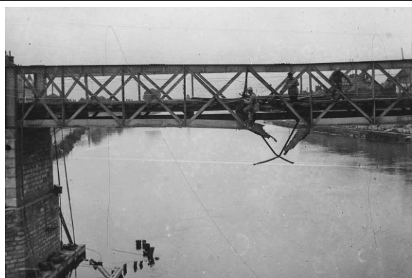
Le pont de chemin de fer appelé « pont de Soissons », à la limite de Clairoix, Margny et Compiègne, est en cours de minage par les sapeurs du Génie. On peut voir que le pont a reçu un obus (« La contemporaine » - BDIC).
