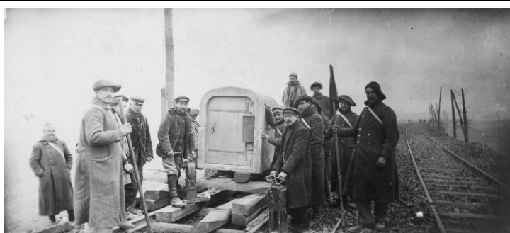
Des prisonniers bulgares, encadrés par des chasseurs à pied, entreprennent la réfection des voies ferrées, en février 1917 (photo « La contemporaine » - BDIC).
