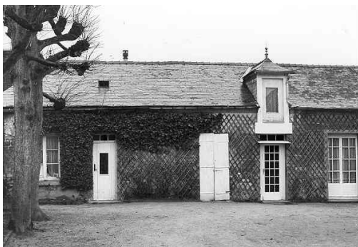
L'aile ouest avant sa restauration
