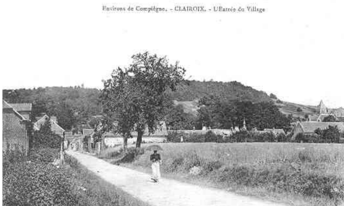
Une photo de la même époque, prise du chemin dit de la Planchette (actuelle rue de la Poste)
