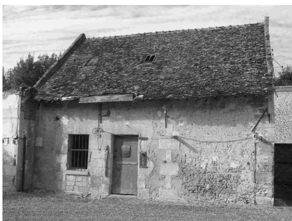
La vieille grange située à l'est du Clos de l'Aronde, destinée à abriter la nouvelle bibliothèque de Clairoix (après rénovation !)
