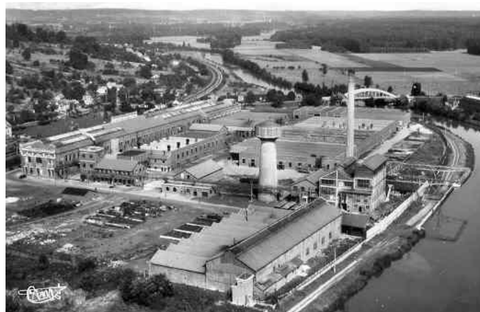
Une autre vue de l'usine, après son agrandissement
