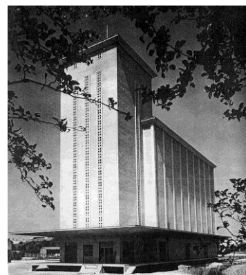
Coopérative agricole : le grand silo
