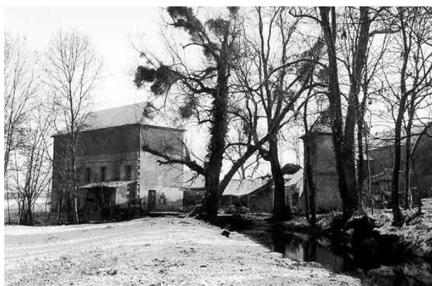
Moulin de Froiselle : le bâtiment actuel, vu de l'ouest
