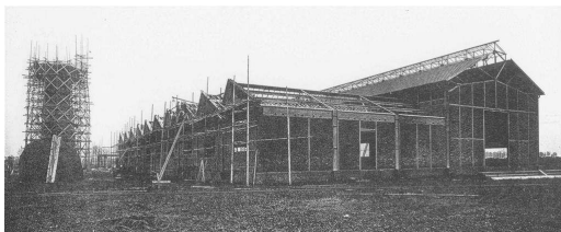
Atelier de mécanique Vue vers l'est
