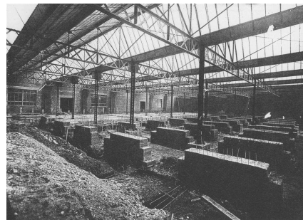
Bâtiment sous shed Vue vers le nord
