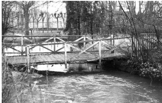
La passerelle sur l'Aronde
