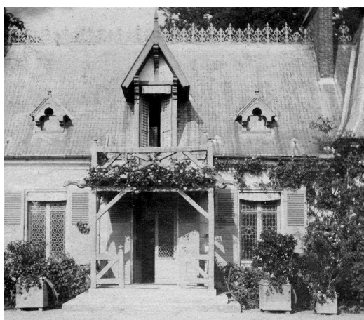
L'entrée principale (le balcon a disparu depuis)
