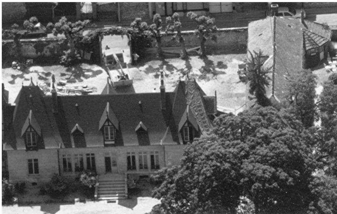
Pendant les travaux... Vers 1988, avant la suppression de la lucarne ouest
