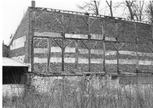
Arrière du bâtiment ci-contre
