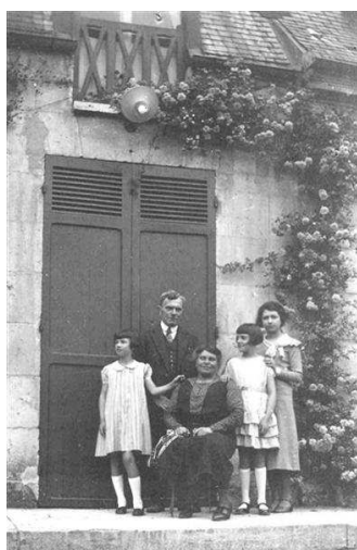
Les Simon devant l'entrée du bâtiment principal, côté rue
