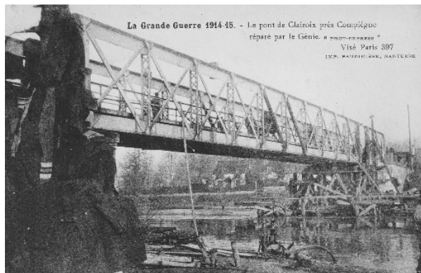
Reliant Clairoix et Choisy-au-Bac, au lieu-dit « Le Bac-à-l'Aumône » : le pont provisoire, de type Pigeaud, installé au début de 1915 par le « génie maritime » ; il remplace l'ancien pont suspendu, détruit par l'armée allemande en septembre 1914.
