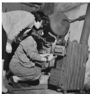
Au sous-sol, la chaudière de l'époque.
