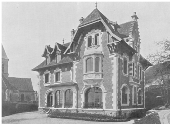
Les façades sud et est (vers 1900).
