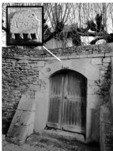
La porte qui permettait de passer du cimetière de l'église à la propriété voisine. Au-dessus, une date (1784). Cette porte a été bouchée en 2013, lors de la reconstruction du mur qui s'était écroulé.
