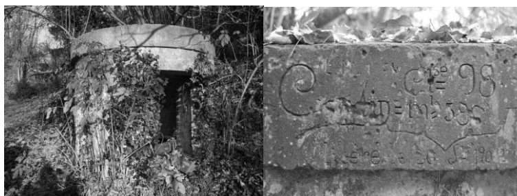
Le poste de garde de la fontaine, rue d'Annel et les inscriptions des soldats chargés d'y monter la garde jusqu'en 1909. Ici, un nom rayé, un numéro matricule et la date de libération du soldat.
