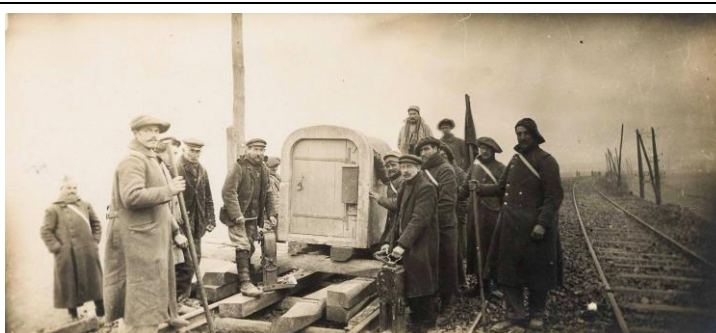
Des prisonniers Bulgares, encadrés par des chasseurs à pieds, entreprennent la réfection des voies ferrées en février 1917 (photo BDIC).
