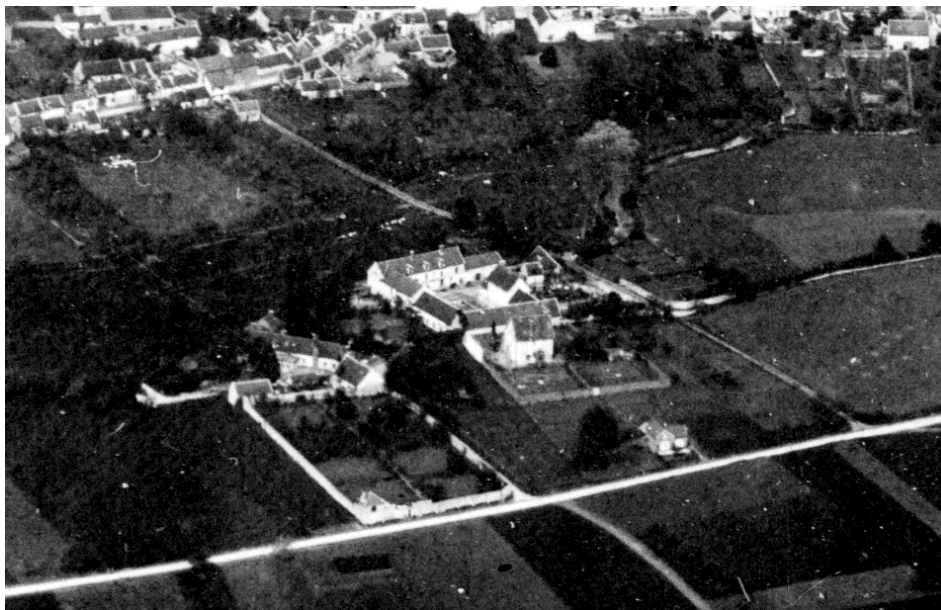
Vue aérienne des moulins Bacot et des Avenelles.
