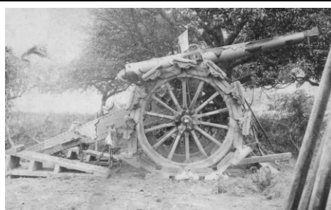
Pièce d'artillerie camouflée selon un schéma précis à trois couleurs et aux endroits particuliers permettant de briser les formes du canon (collection de l'auteur).
