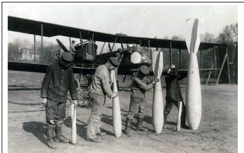
Les bombes ou torpilles que le bombardier gotha peut larguer en chapelet à raison de 600 kg par appareil. En arrière-plan, l'avion que la firme Goather Waggonfabrik a développé en 1917. Cette nouvelle menace surprend et terrorise les habitants de Clairoix (Photo de l'auteur).
