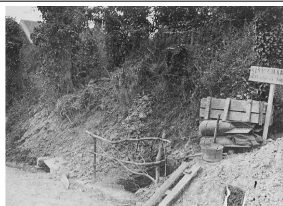
Piégeage d'un carrefour à l'aide de quatre obus de 240 mm placés de chaque côté de la route. Ici, il s'agit de Coudun. À Clairoix, le dispositif est le même (collection BDIC).
