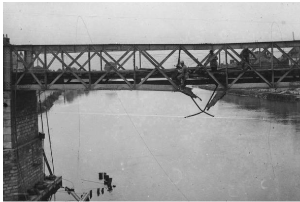
Le pont de chemin de fer appelé « pont de Soissons », à la limite de Clairoix, Margny et Compiègne, est en cours de minage par les sapeurs du Génie. On peut voir que le pont a reçu un obus (archive BDIC).
