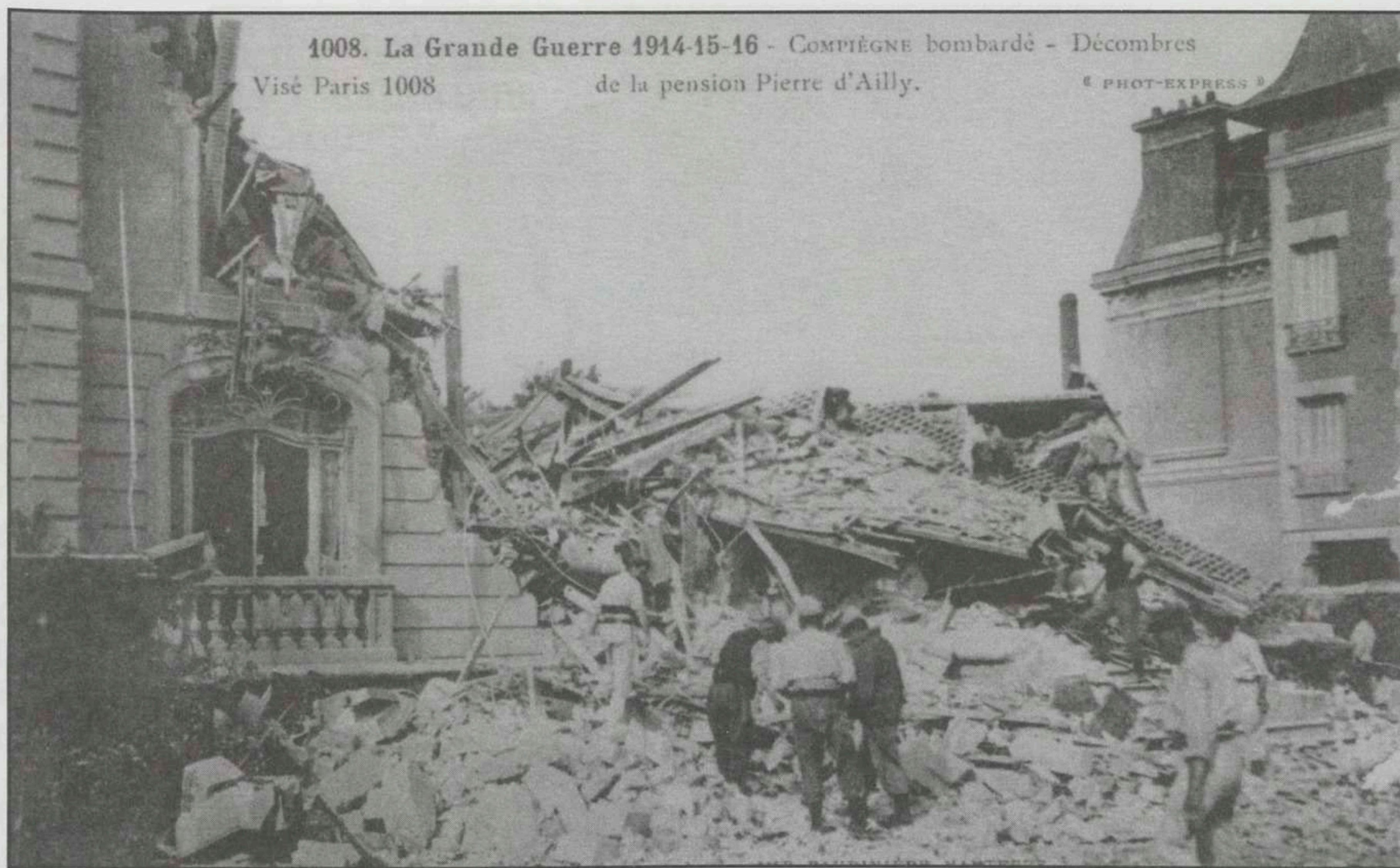
Compiègne : décombres de la pension Pierre d'Ailly, fréquentée par G. Guynemer en 1912, bombardée et détruite en 1915.
