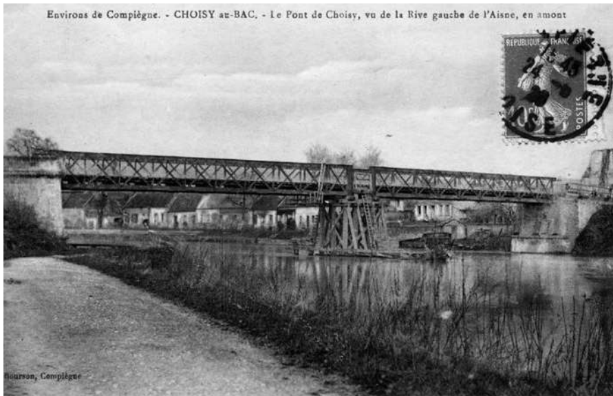
Le deuxième pont de Choisy encore en cours de construction (Collection B. Morel)
