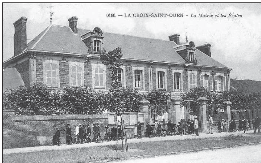
L'école laïque et républicaine intégrée dans les bâtiments de la mairie
