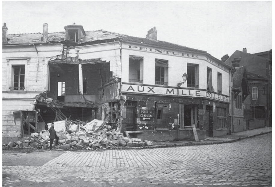
Dégâts occasionnés par un obus de 380 sur une façade rue du Harlay.
