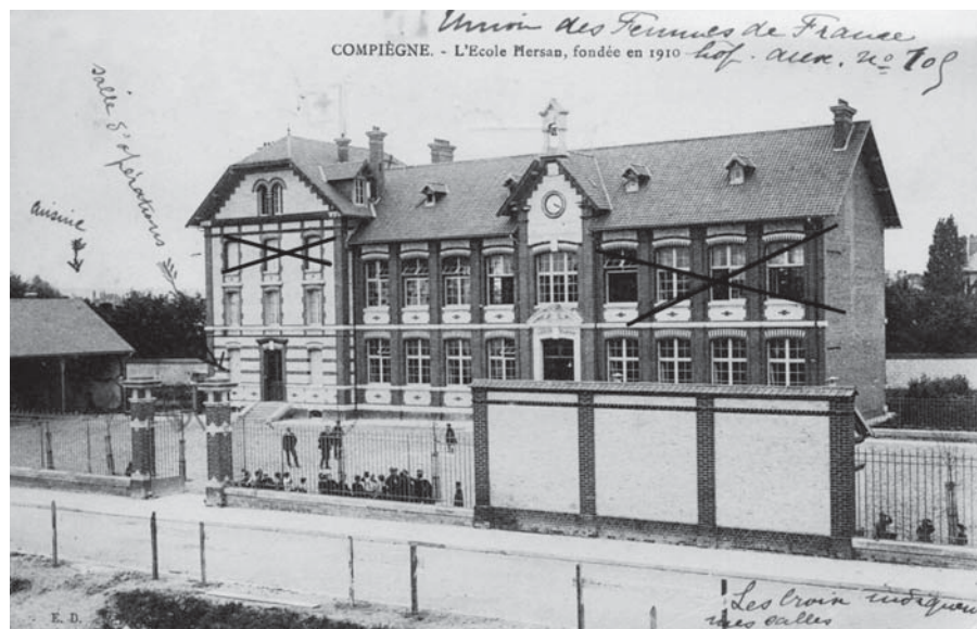
Jeanne a rajouté au crayon le drapeau de la Croix Rouge sur la cheminée ainsi qu'au portail, flanqué drapeau français. Deux grandes croix à l'étage indiquent les salles dont elle était responsable. Dans un premier temps la salle d'opération ne servit pas car l'hôpital ne reçut que des malades.
