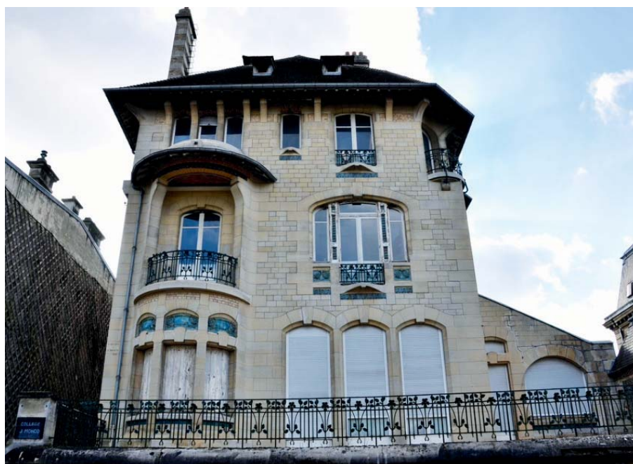
Villa Marcot, façade nord-est
