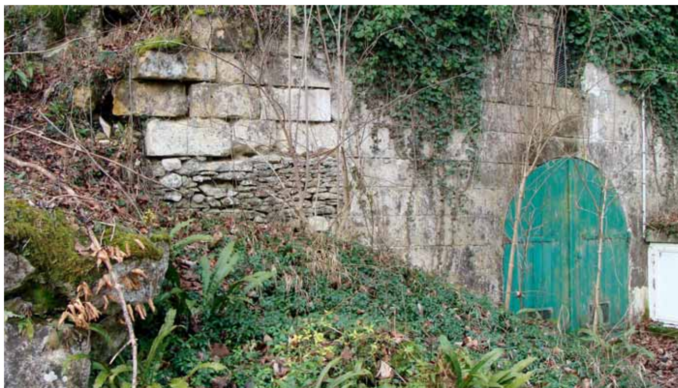
Entrée de la source du Haloy. Une fenêtre en ogive s'ouvre au-dessus de la porte et l'eau se déverse dans un petit bassin qui a pu faire office de lavoir. Il y a de nombreux graffiti datant de la moitié du XVIII e siècle.
