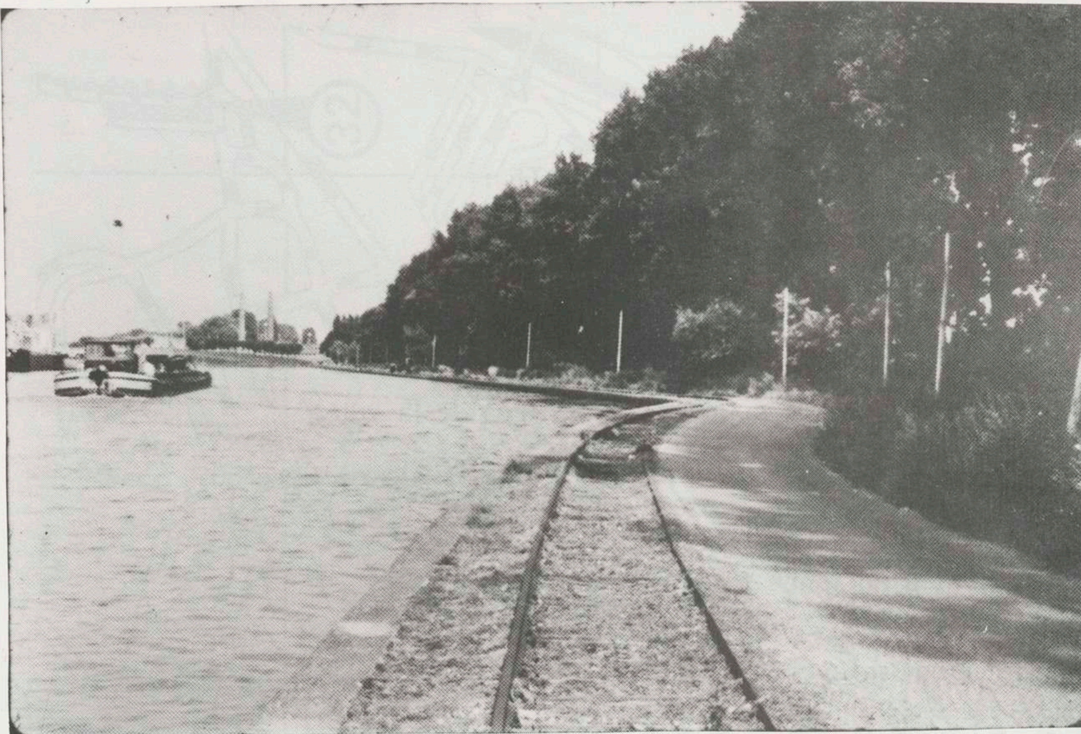
Le canal de St-Quentin à proximité du port de l'Isle. Encore bien visibles, la voie en bordure du canal et les poteaux qui supportaient le fil d'alimentation électrique des tracteurs. (Ph. F. Beaucire)
