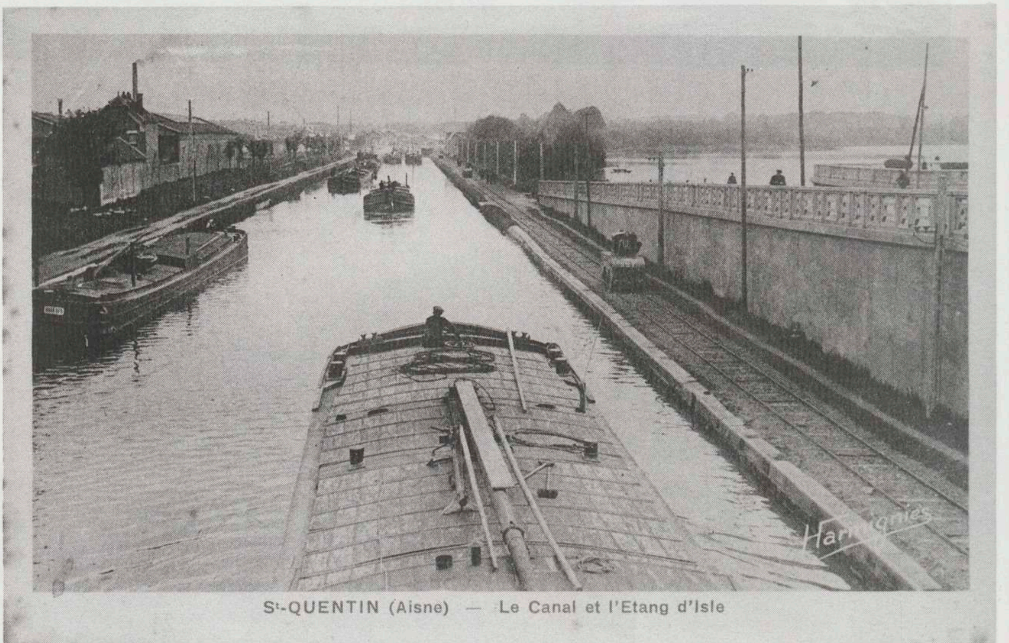
Canal vu du pont de l'Isle Traction électrique des bateaux en action. (Carte postale ancienne - coll. J.Leroy)
