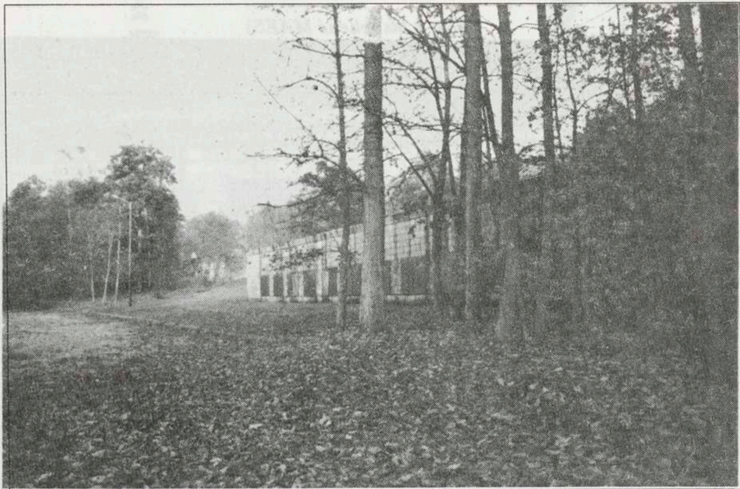
Photo 5 bis : cantonnement pour le personnel (cliché MAES)
