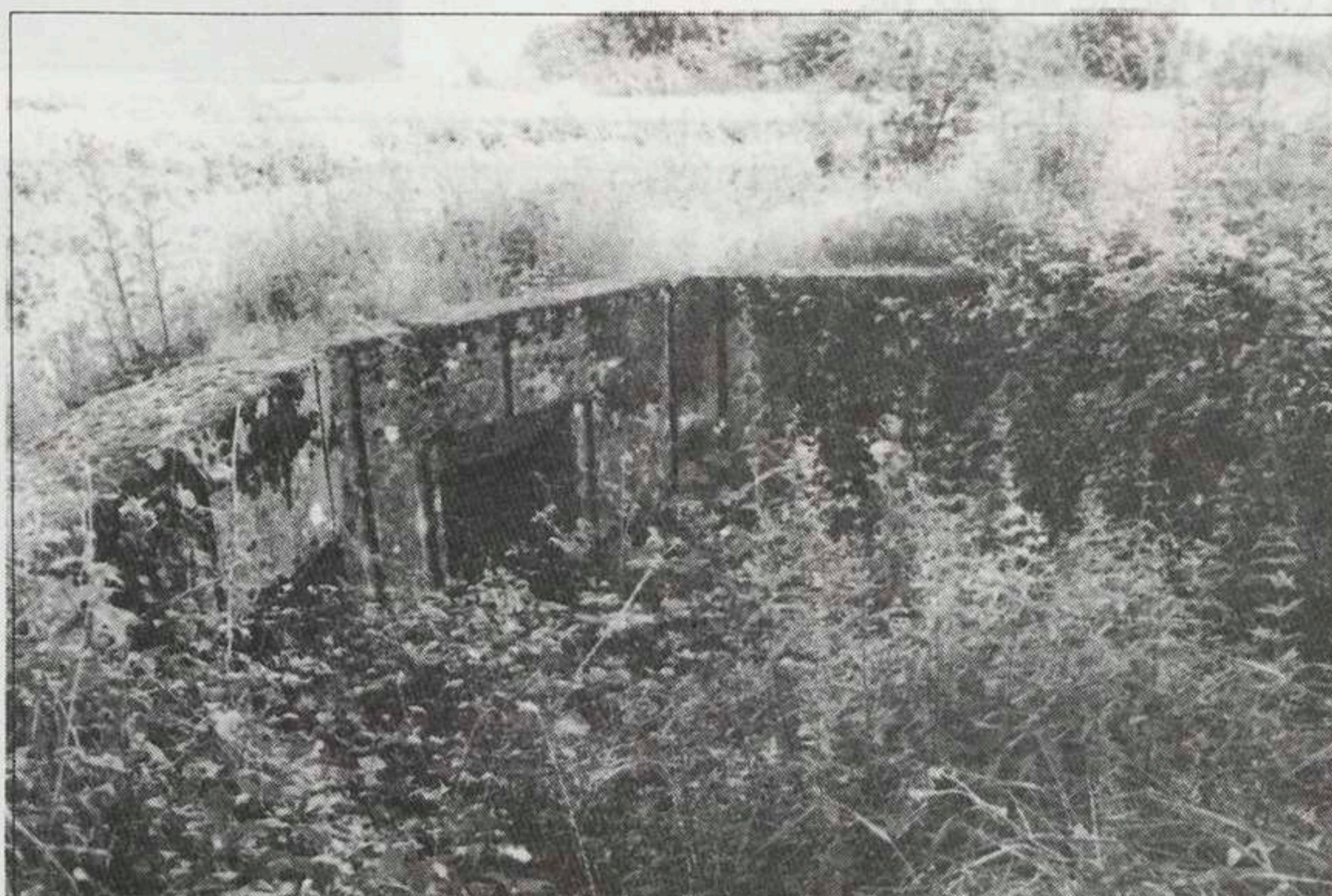
Photo N° 1 : emplacement de DCA, Bois de Laffaux, lieu dit Le Noyer. (cliché MAES)
