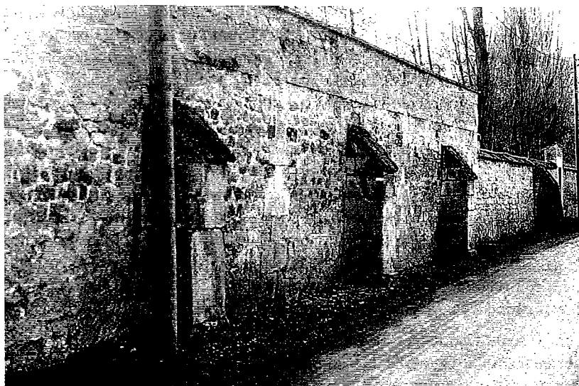
Fig. 4 : Derniers vestiges médiévaux de la "Maison de la Tour" à Saint-Corneil les Verberie : des contreforts à ressauts (photo : J.-M. Popineau).
