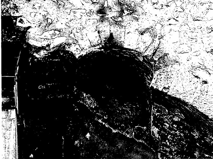
Figure 36 : vestiges d'une porte haute dans la tour sud, détruite et bouchée par le percement d'un escalier droit ayant perturbé le parement extérieur de la tour, à l'époque moderne.
